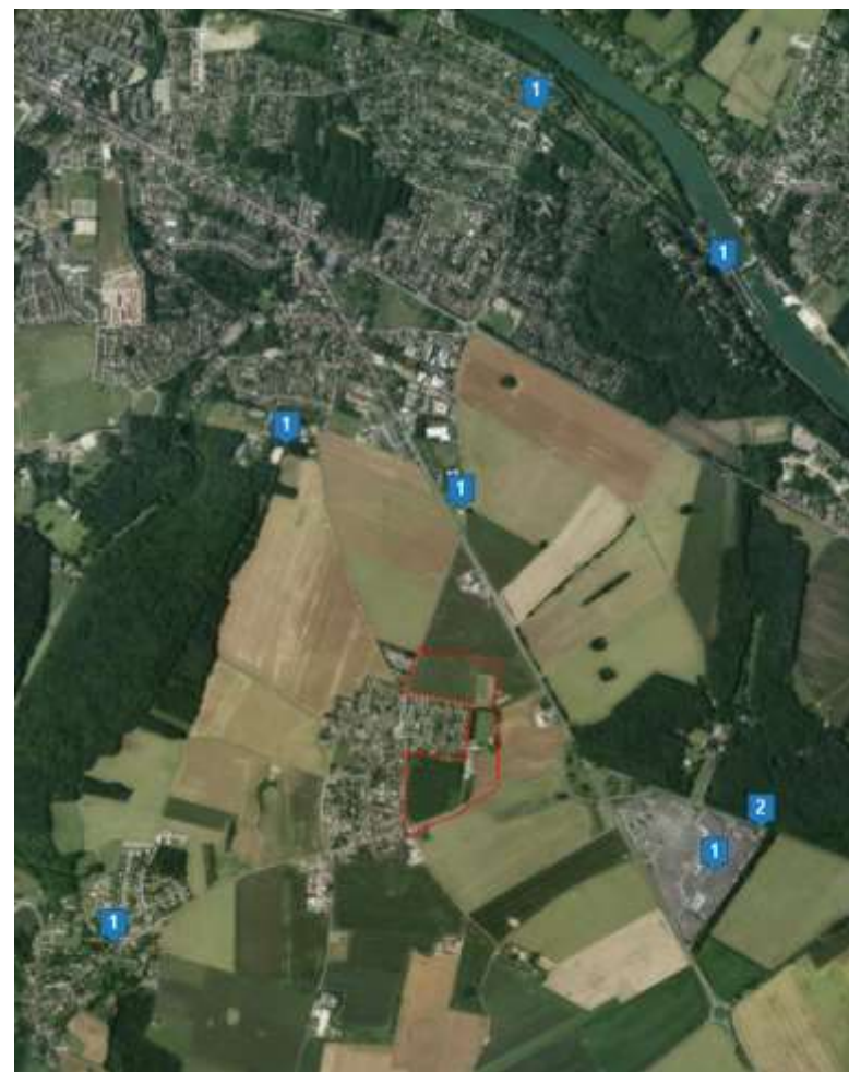
FIGURE 133 - RESEAU D'ANTENNES D'EMISSIONS (ANRF)
